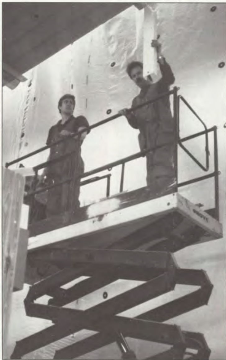
Högt i tak, men med en sän här går det lätt. Styrbar både i höjd och sidled från plattformen. Stora sjok av plast hänger från tak till golv för att skydda den känsliga produktionen.
