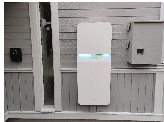
Polarium Homevolt batteri 13,4 kWh (i mitten)
