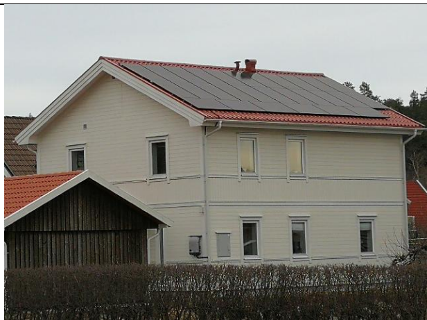
Solpaneler, Suntech och växelriktare, Fronius
