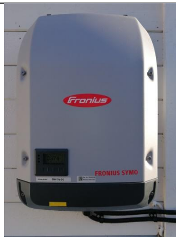
Växelriktare konverterar likström till växelström
